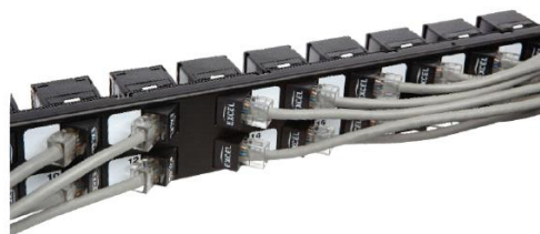
D. Moduły Keystone zamontowane w patch panelu kątowym
